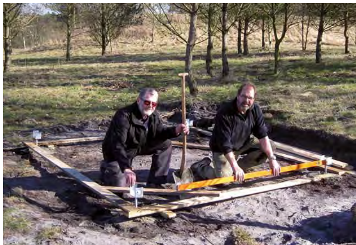
Jørgen Brinck og John Grabe er her netop færdige med at støbe fundament til det første lynshelter mellem hul 5 og 6 på Skoven.
