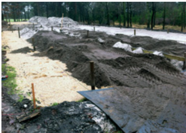
Oven på råjorden lægges der 10 cm drænsand som rettes af i samme plan som spilleoverfladen.
