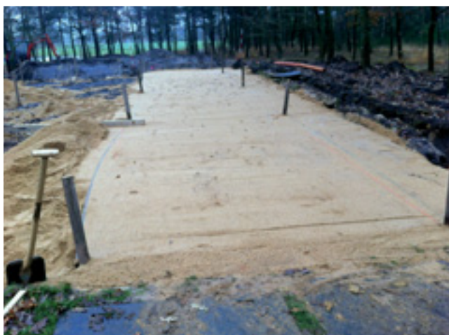
Oven på råjorden lægges der 10 cm drænsand som rettes af i samme plan som spilleoverfladen.
