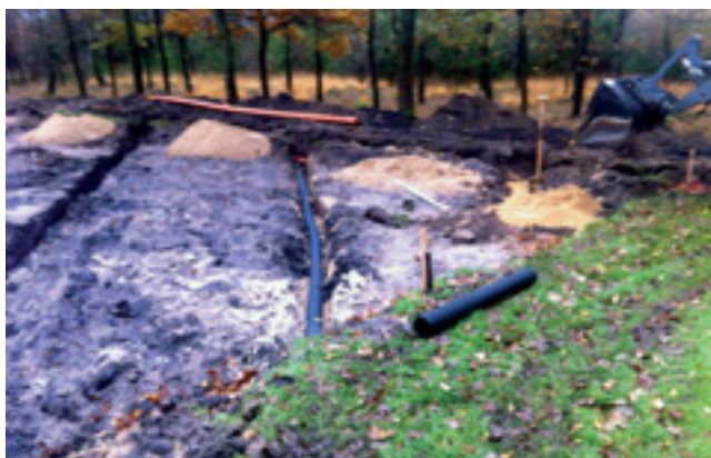
Her lægges der dræn i råjorden i hele teestedets bredde med en afstand på 4 meter for at dræne det efterfølgende vækstlag.
