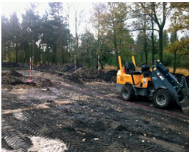
Dette afrettes med et fald på 1 cm pr. løbende meter fra forkant til bagkant.
